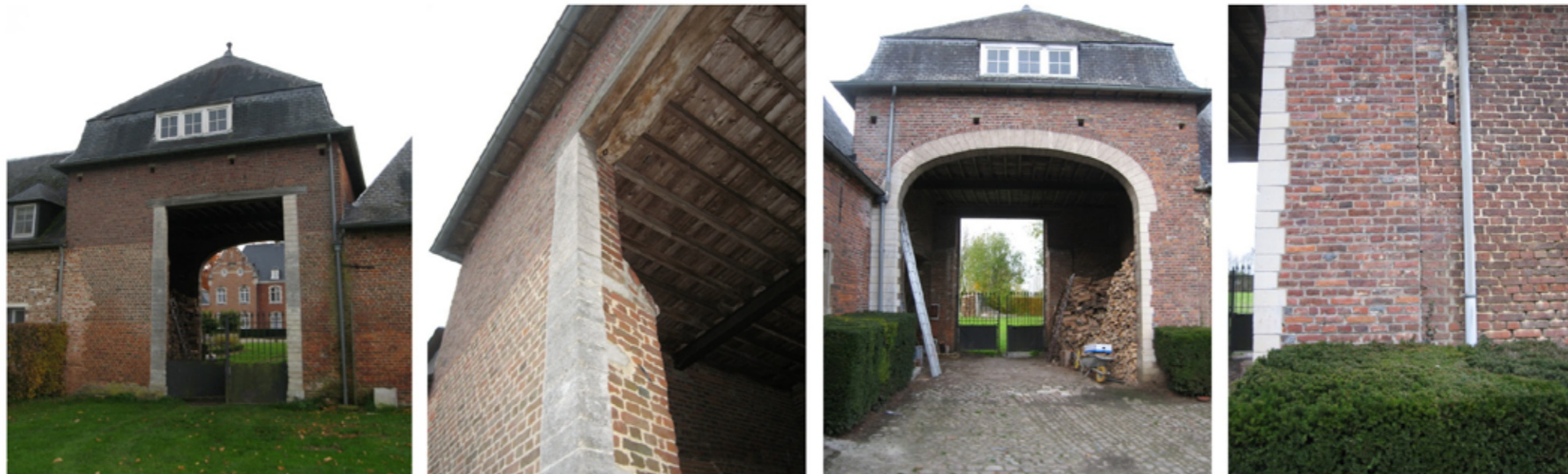
poortgebouw : opvallende gelaagdheid van het metselwerk in de noordgevel, verschil in muurdikte, gevel kant binnenkoer + detail staande voeg aan hoek wachterswoning
