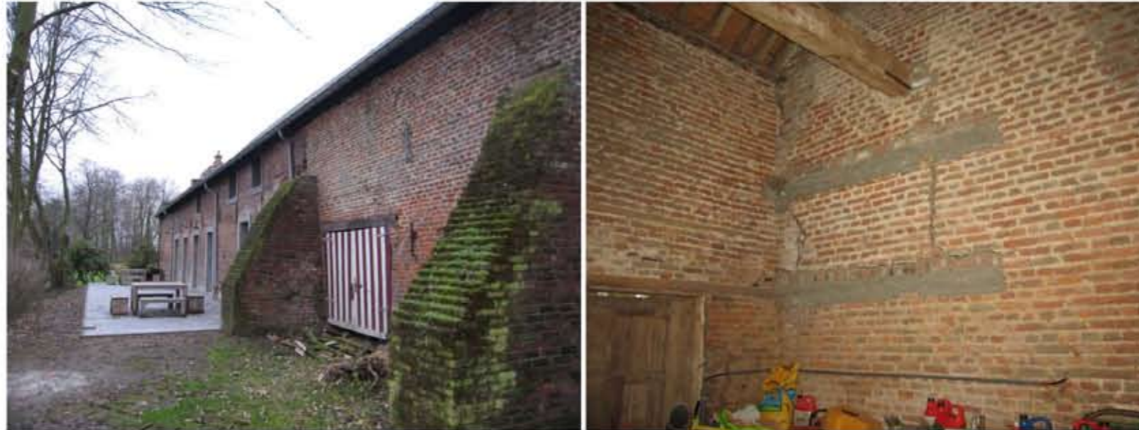
hoekschuur : steunberen en ankerbalken houden de oostegevel overeind.
