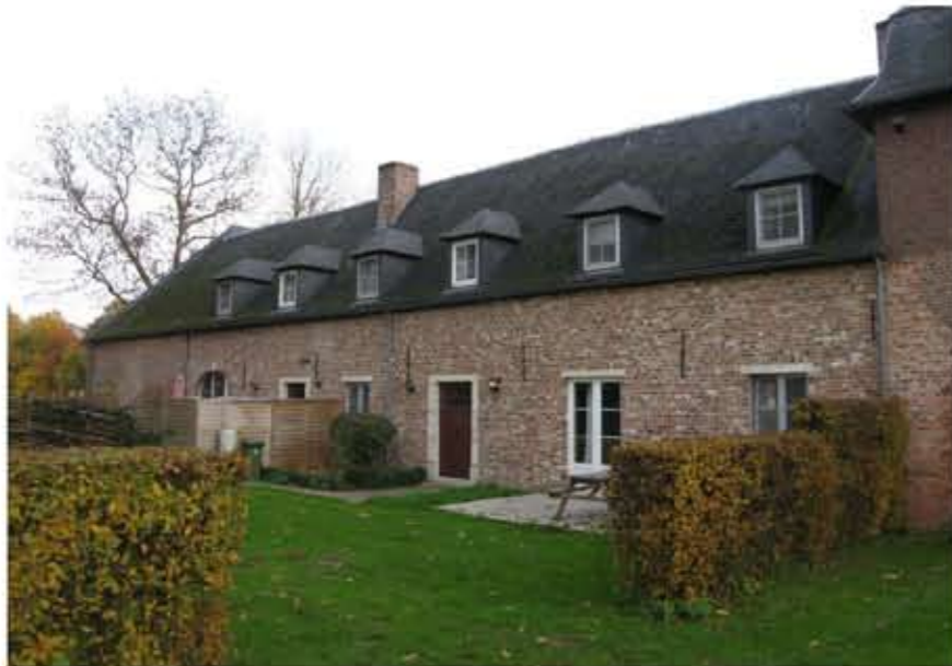
herinrichting en uitbreiding van de wachterswoning (habitation du garde) op het einde van de twintigste eeuw
