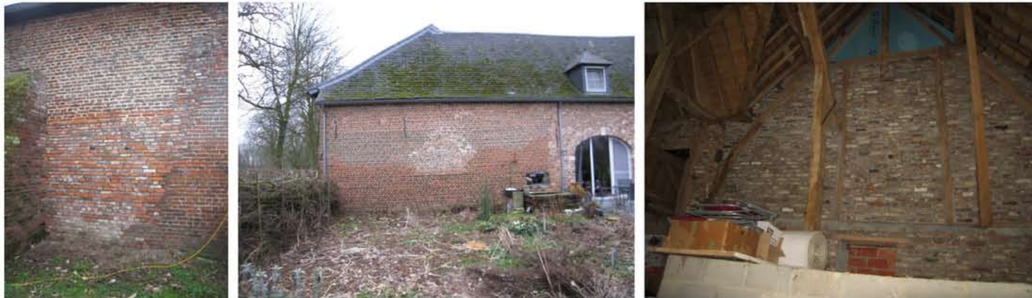
hoekschuur : sporen van opeenvolgende bouwfases en herstellingen in de oostgevel, dichtgemetselde raamopening in de noordgevel, recent gemetselde wand in het gebinte tussen hoekschuur en conciërgewoning
