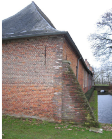
steunbeer in de noordwestelijke hoek van de houtschuur
