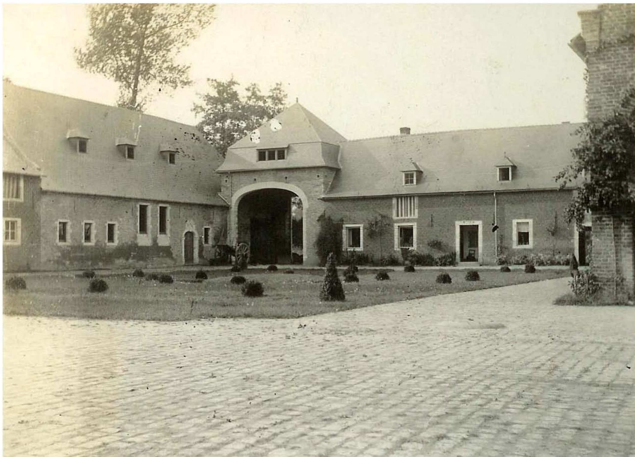
op deze archiefoto (vermoedelijk van na 1924, op foto's uit 1914 is te zien dat de binnenkoer verwilderd was, er groeide zelfs bomen tegen het kasteel) zien de gevels en de daken van houtschuur, poortgebouw en noordvleugel er splinternieuw uit. Het houten schrijnwerk was nog niet wit geveerd.
